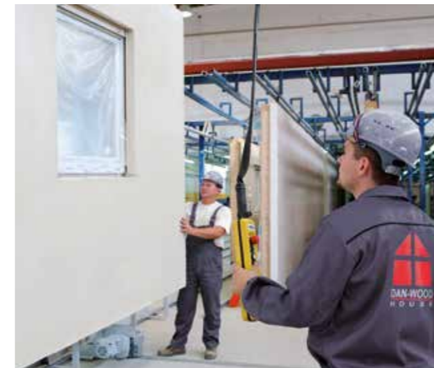
Die Wände werden in der Fabrik vorgefertigt...
