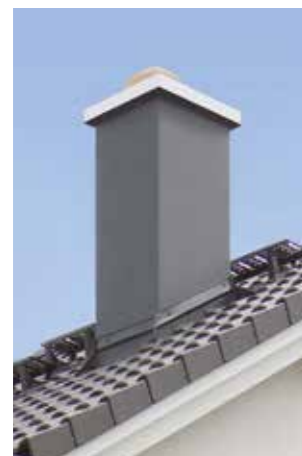
Der Schornstein wird in der Dachfarbe gestrichen***
