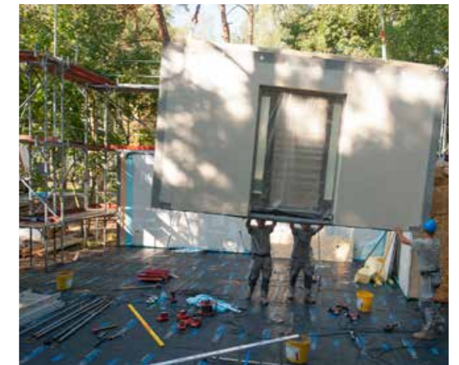
... auf LKW zum Bauplatz transportiert...
