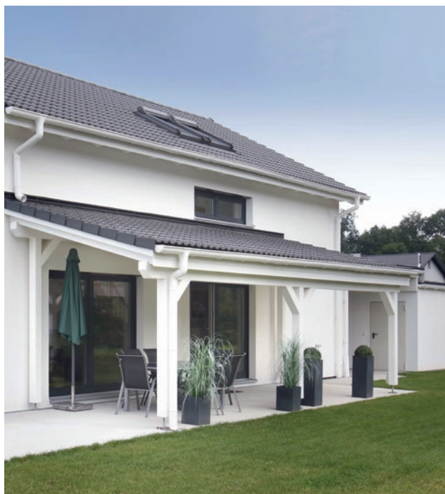
Solides Dach über der Terrasse
