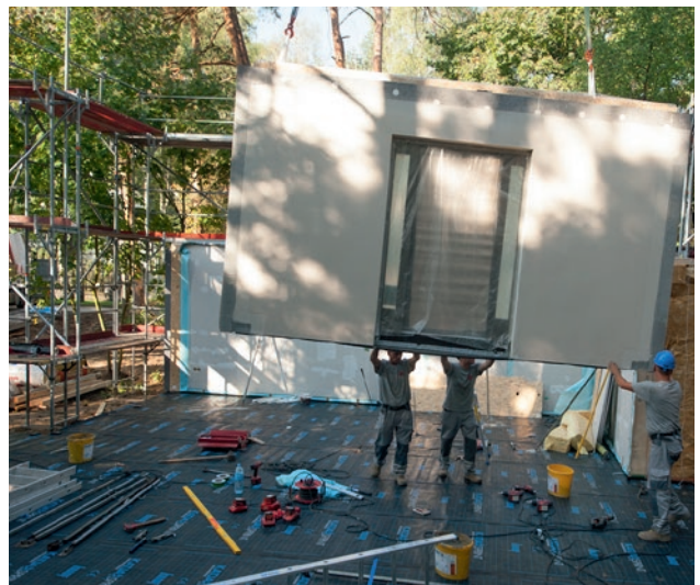
... auf LKW zum Bauplatz transportiert...
