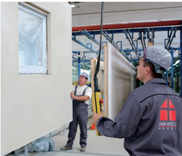
Die Wände werden in der Fabrik vorgefertigt...
