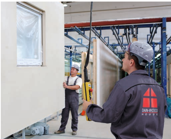
Die Wände werden in der Fabrik vorgefertigt...
