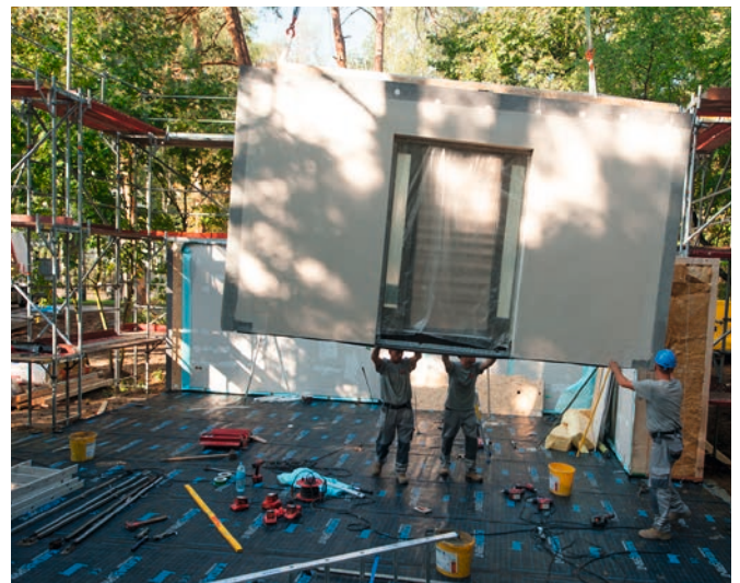
... auf LKW zum Bauplatz transportiert...
